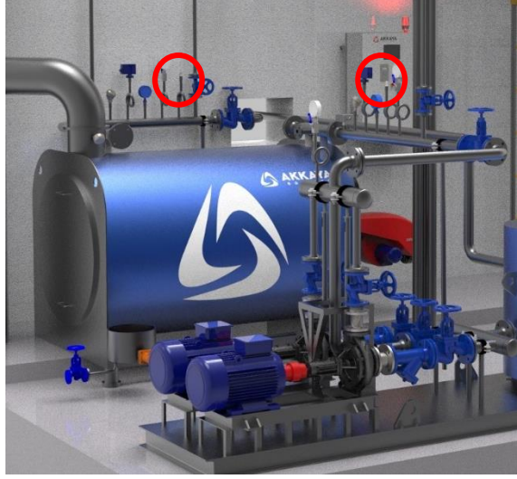
Şekil Ek 2.5 Basınç Tranmitteri
