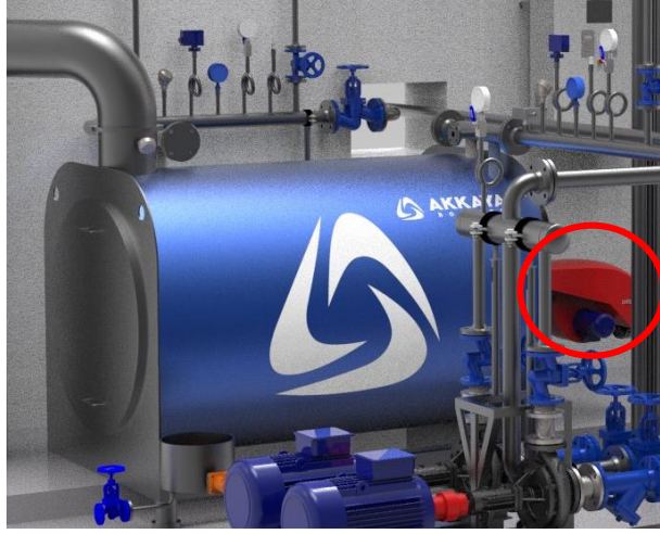
Şekil Ek 2.1 Kazan Üzerindeki Brülör
